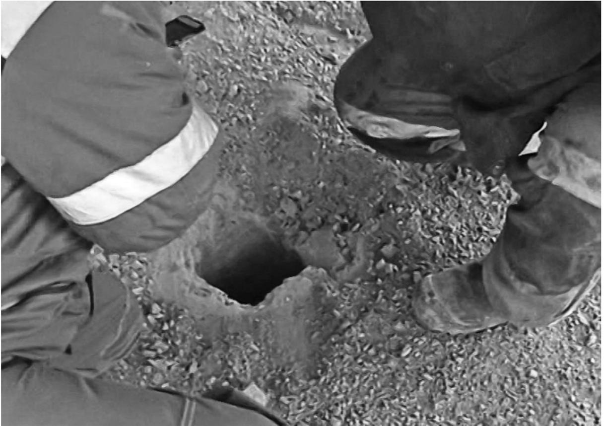
*Рисунок 4.9 – Вид сбоку забуренной скважины*
