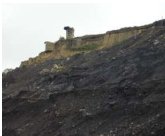
Рис.3.1.3. Отработка предохранительного целика под промплощадкой шахты «Северный Маганак».
