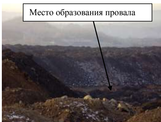
Рис. 3.1.2. Отсыпка внешнего отвала разреза «Северный Маганак» в провал «Шахты им. М.Косогоровой»
