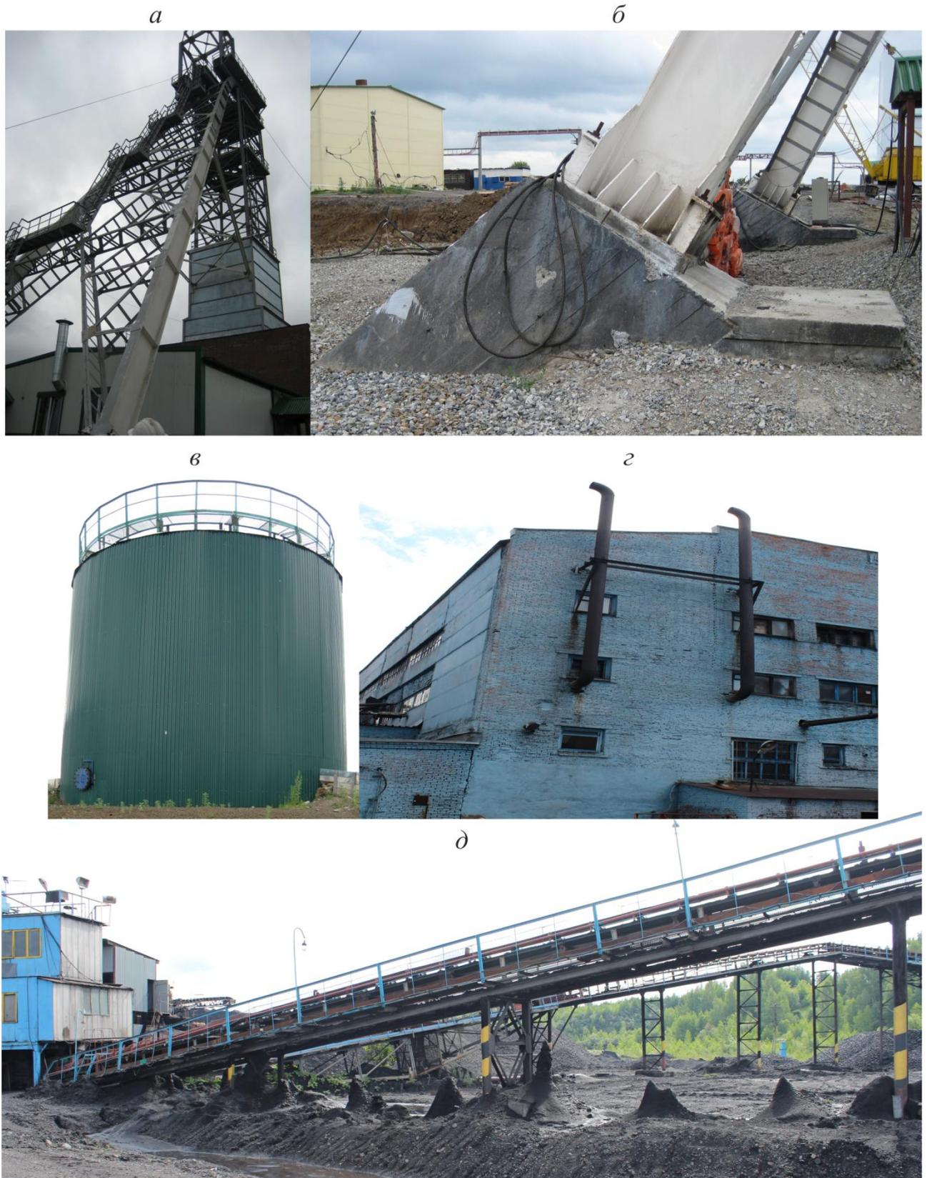
Рис. 1.4. Общий вид укосного копра (а) и его опор (б), резервуаров для хранения жидкого топлива (в), фасадов (г) и фундаментов (д) здания и галерей обогатительного корпуса
