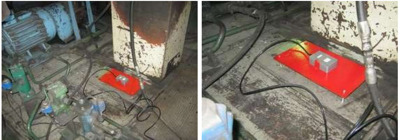
Рисунок 4.1 - Установка в кузове датчика для измерения углов наклона
