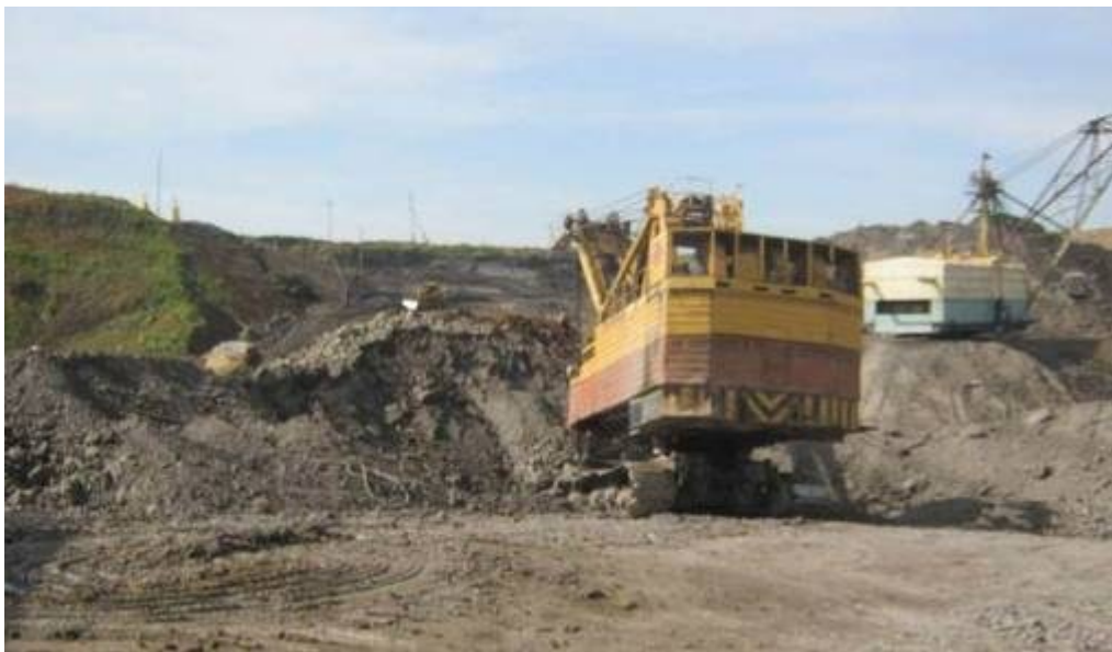
Рисунок 2.15 - Работа экскаватора ЭКГ-10 на рабочей площадке с увеличенным уклоном и просадкой грунта
