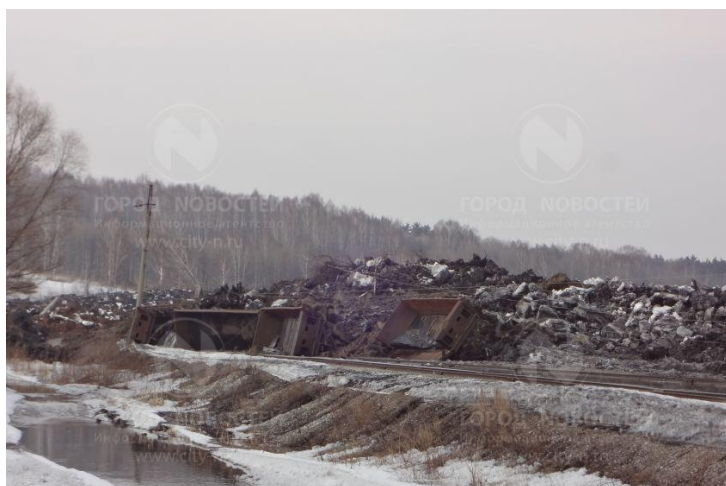
Рис. 1. Фото повреждений после обрушения отвала разреза «Заречный»
