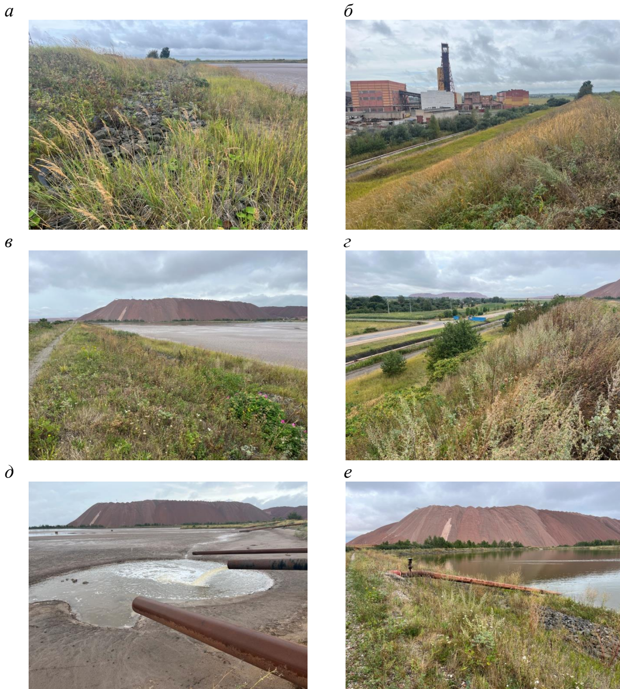
Рисунок 1 – Ограждающие дамбы отработанного шламохранилища №3 первого рудоуправления ОАО «Беларуськалий» (фотографии на 22.08.2024 г.): а, б и в, г – соответственно верховые и низовые откосы ограждающих дамб;
