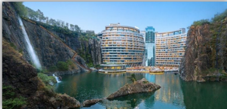
Рисунок 1 – пример строительства отеля в открытой горной выработке, г. Хан хай.
