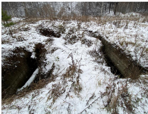
Рисунок 3 – Вентиляционные каналы, имеющие выход на поверхность
