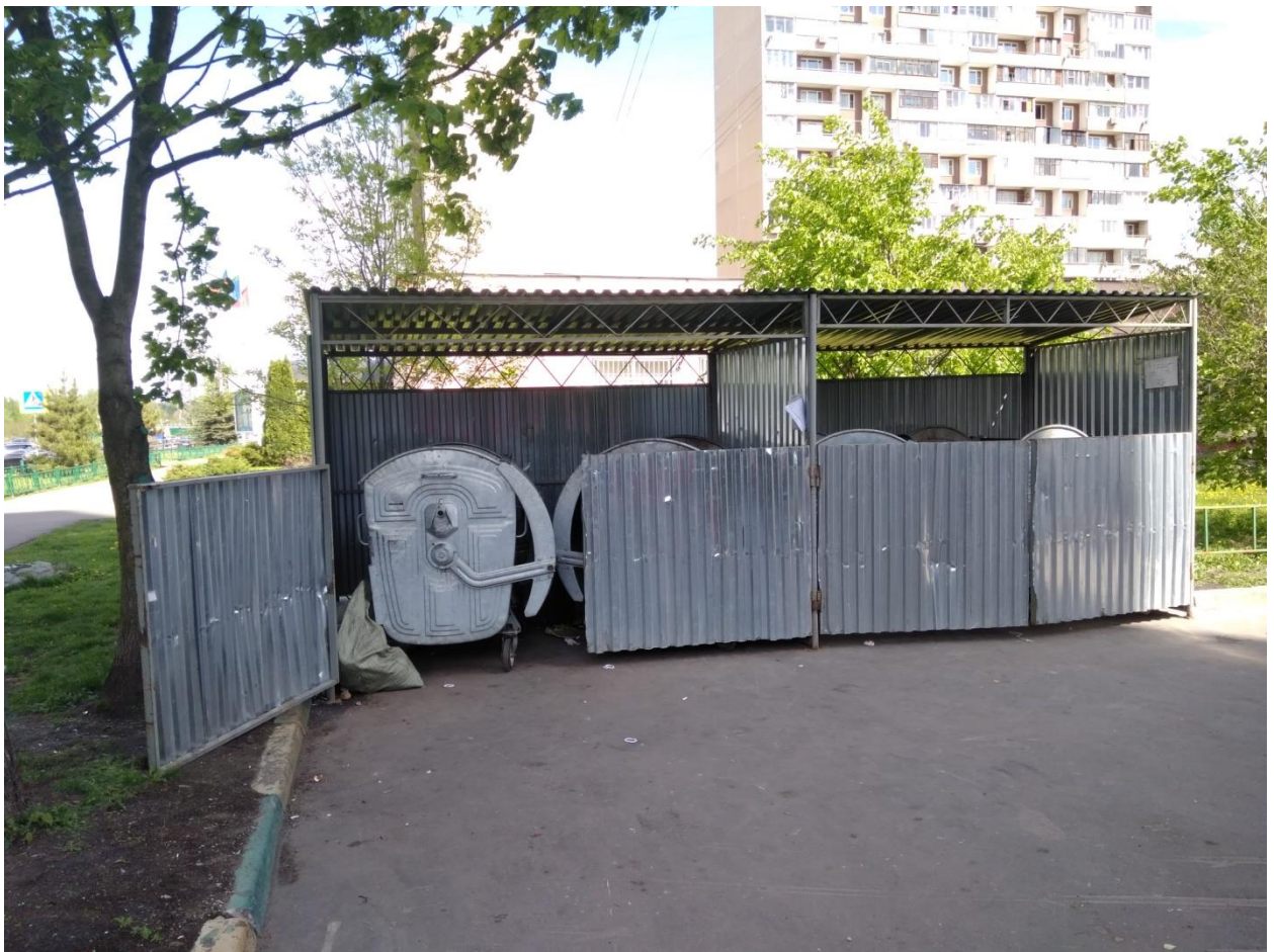
Рис. 4 – Крытая площадка для контейнеров
