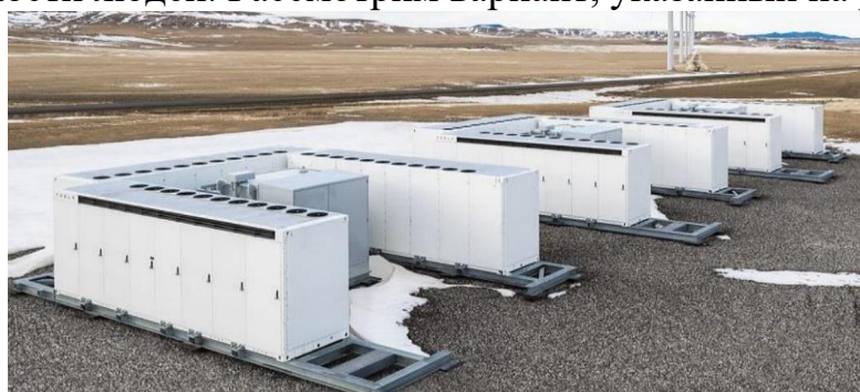
Рис. 2. Расположение блоков Tesla Megapack [6]
