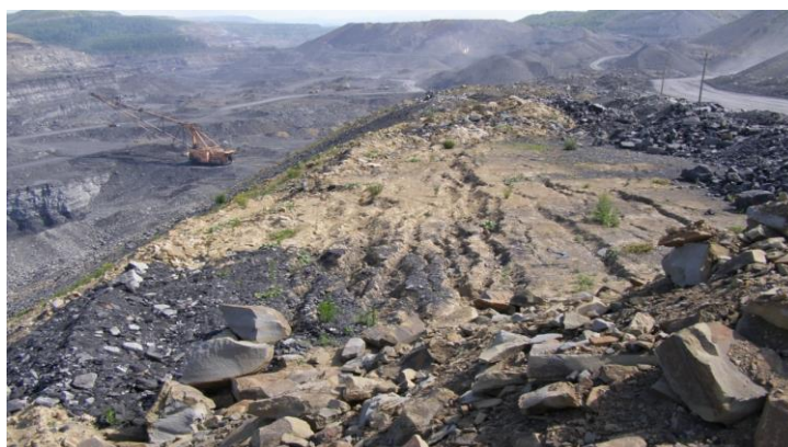
Рис.1. Деформации отвала Внутренний 5-2
