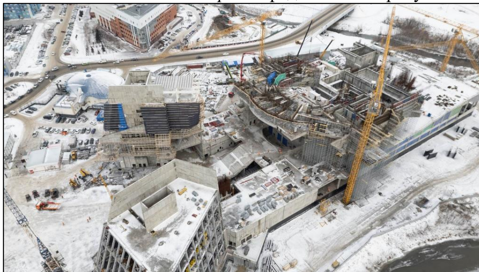
Рисунок 1 – Строящийся музейно-театральный комплекс
