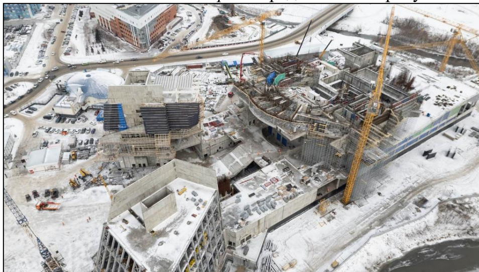
Рисунок 1 – Строящийся музейно-театральный комплекс
