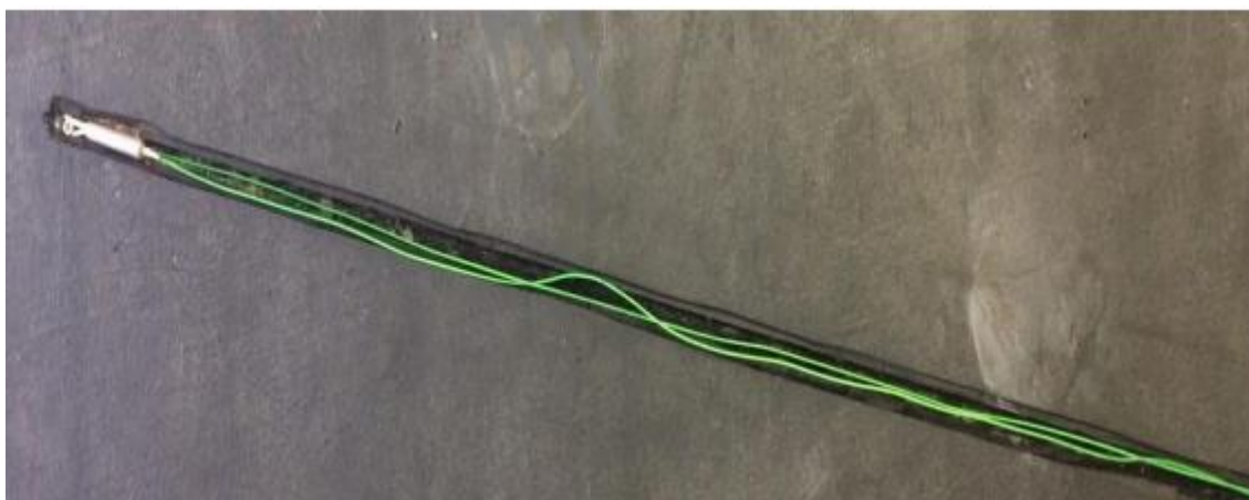
Рисунок 2 – Укладка провода в подготовленное углубление (камерное)
