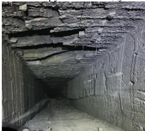
Рисунок 4 - Отклонение комплекса при проведении камеры и подрезка междукamerного целика
