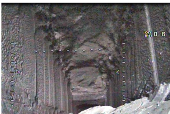
Рисунок 2 – Отслоение неустойчивых пород кровли и увеличение высоты целика
