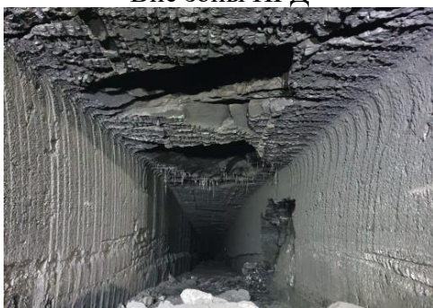
Рисунок 3 - Разрушение междукamerного целика при длительных простоях
