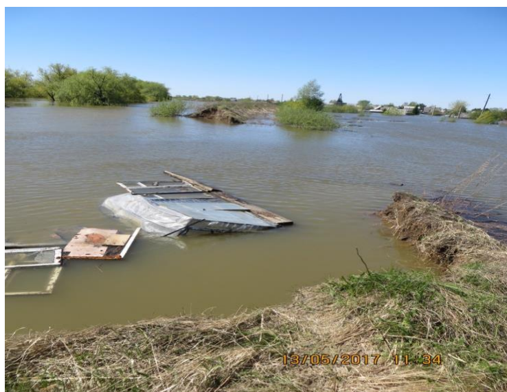
Рис. 3. Проран в теле противопаводковой дамбы на р. Ишим в результате паводка 2017 года
