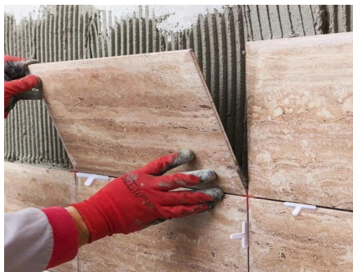
Рисунок 2 – Выполнение кладки керамической плитки
