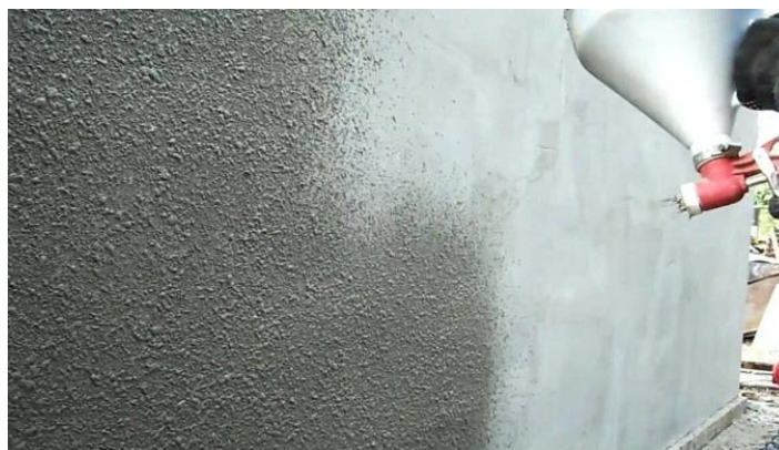
Рисунок 3 – Устройство фасада методом набрызга
