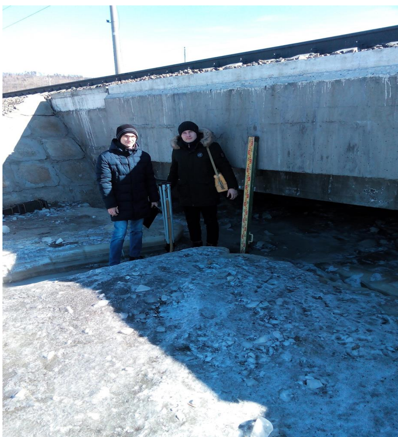
Рис. 2. Нарастание наледи под железнодорожным мостом
