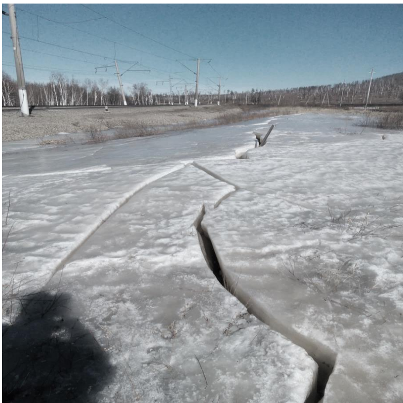
Рис. 1. Формирование бугра наледи у железнодорожной насыпи
