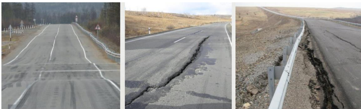
Рисунок 1 – деформации на автомобильной дороге в зоне вечной мерзлоты
