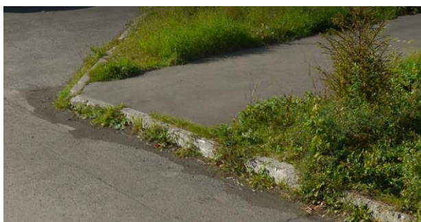
Рис. 3 – Сегмент разрушенного бортового камня
