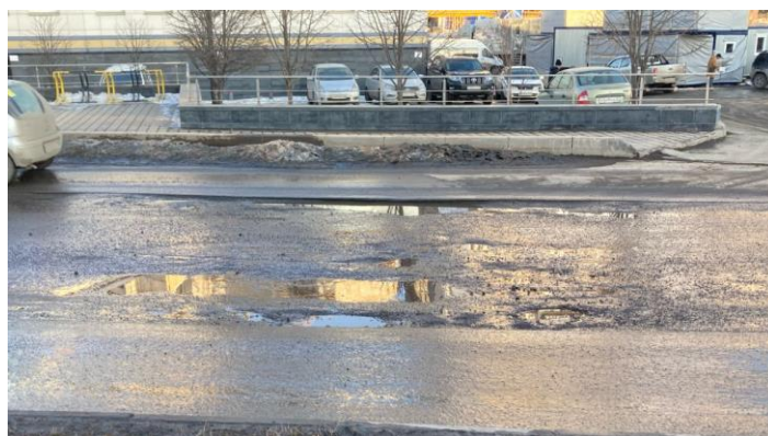
Рис.2 – Разрушение существующего асфальтобетонного покрытия
