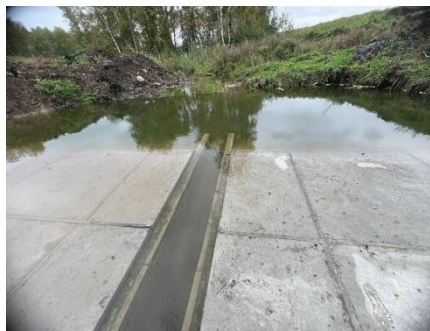
Рис. 2 Противоналедневый лоток
