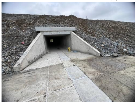
Рис. 1 Прямоугольная труба под автомобильной дорогой
