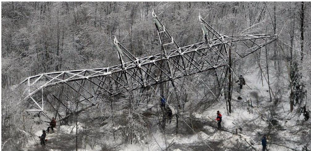
Рис. 1 Пример падения решетчатой конструкции с малыми повреждениями
