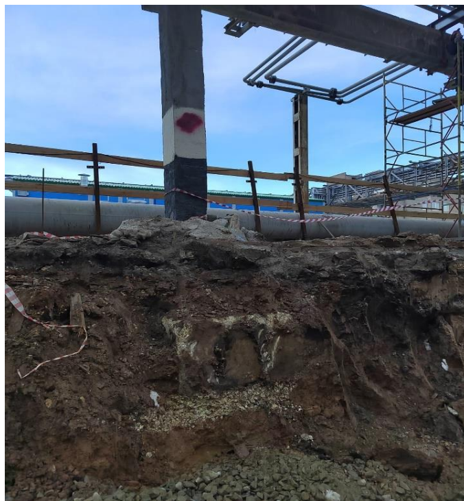
Рис. 2. Подработка части фундамента существующей железобетонной эстакады
