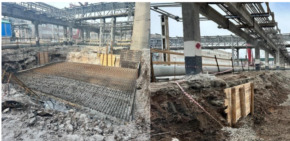
Рис. 8. Забутовка откоса
