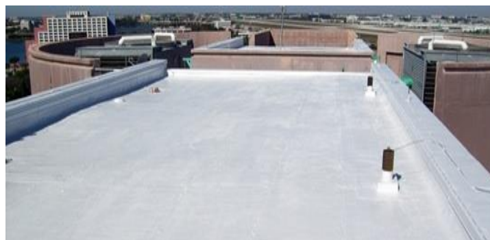
Рисунок - 1. Вид кровли из ТРО-мембраны
