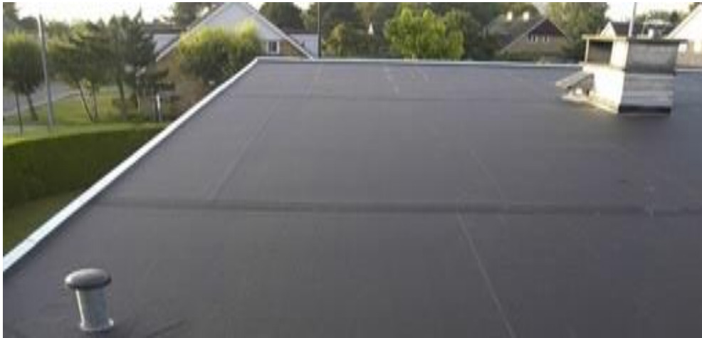
Рисунок - 2. Вид кровли из EPDM-мембраны
