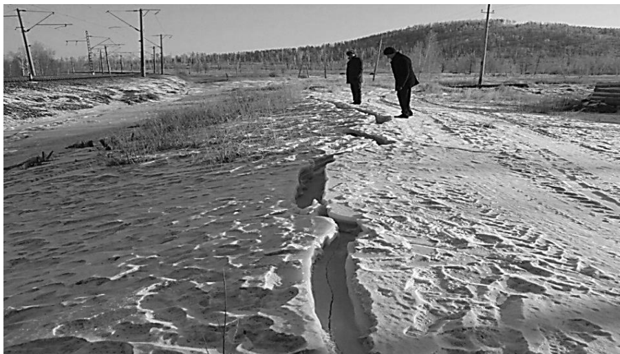
Рисунок 1 – Образование бугра наледи вдоль насыпи железной дороги на перегоне Тургутуй–Сохондо в зимний период (высота 2,5 м, март 2014 г.)
