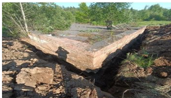
Рис. 2. Общий вид на шурф свайно-ростверкового фундамента второго недостроенного здания
