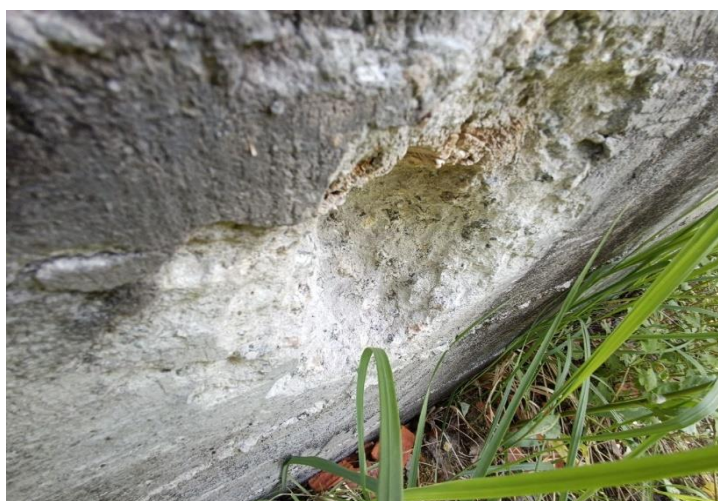
Рис. 6. Расслоение бетона ростверка, низкая морозостойкость участка
