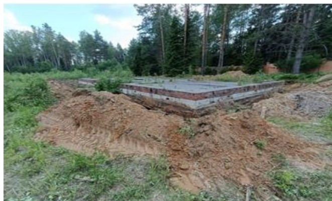
Рис. 1. Общий вид на шурф свайно-ростверкового фундамента первого недостроенного здания
