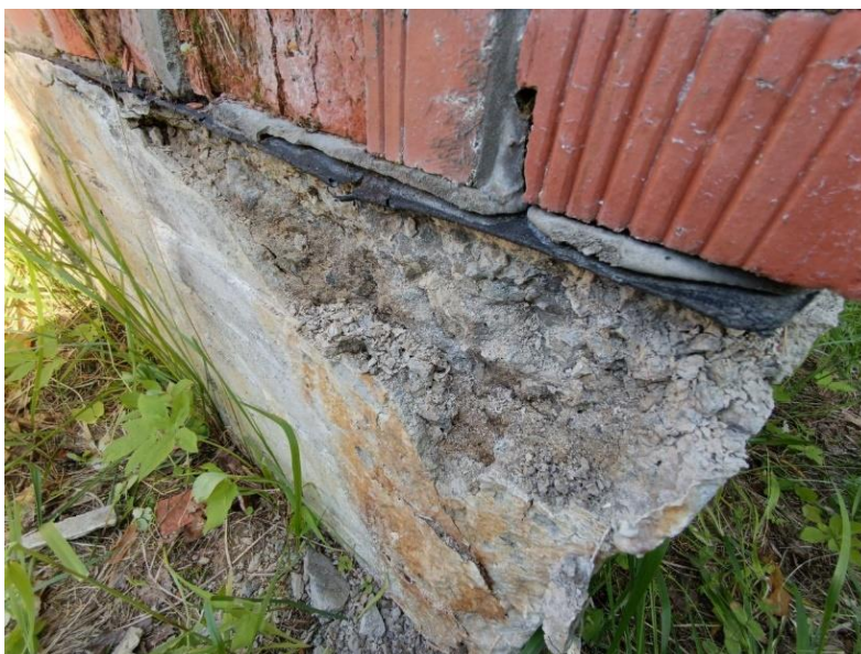
Рис. 5. Сколы бетона ростверка
