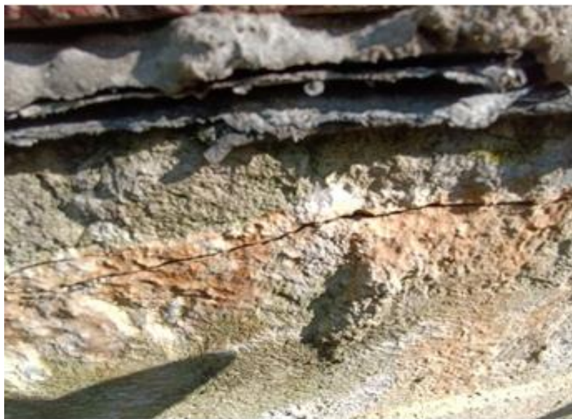
Рис. 4. Поверхностные высолы и расслоение бетона ростверка
