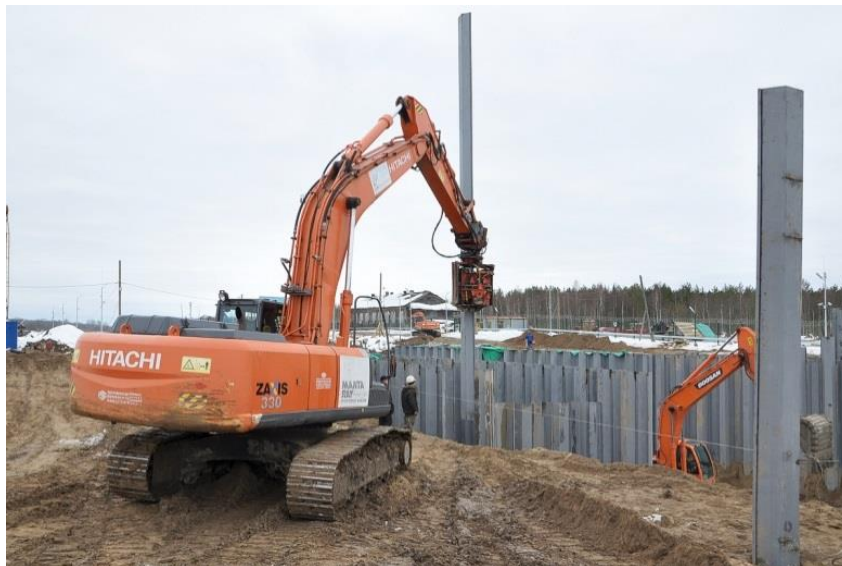
Рисунок 4 - Погружение шпунта вибропогружателем
