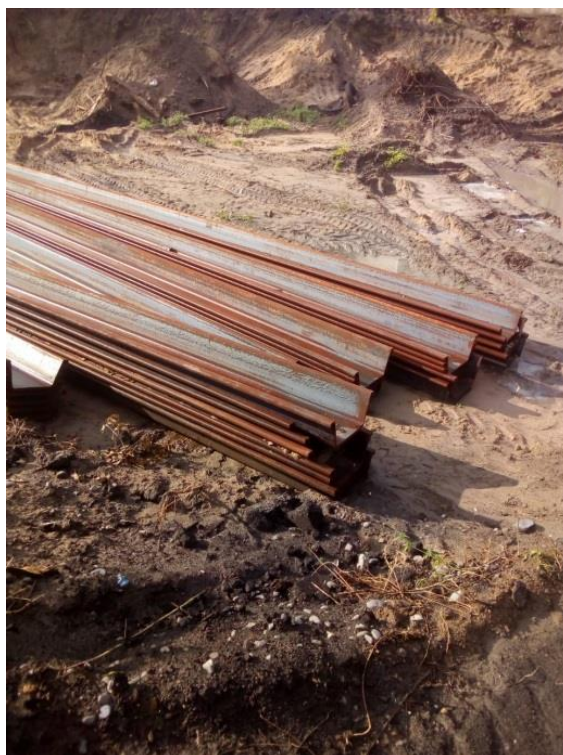
Рисунок 8 – Шпунтовые сваи до монтажа
