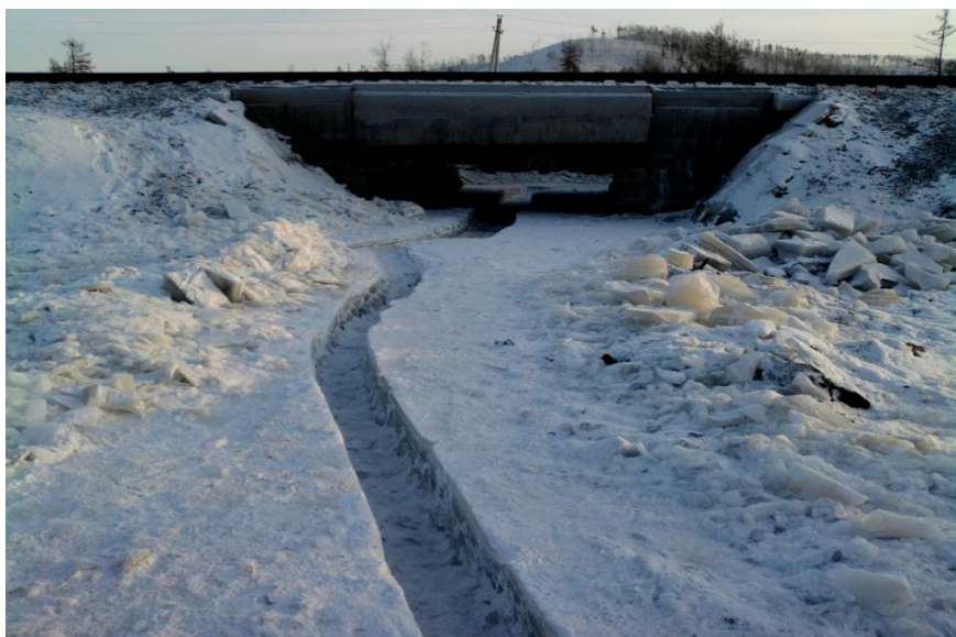
Рисунок 1 – Образование наледи под железнодорожным мостом в зимний период 2013 г.
