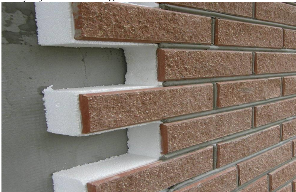
Рис.1 Архитектурная фасадная пенополистирольная панель с декоративным покрытием.
