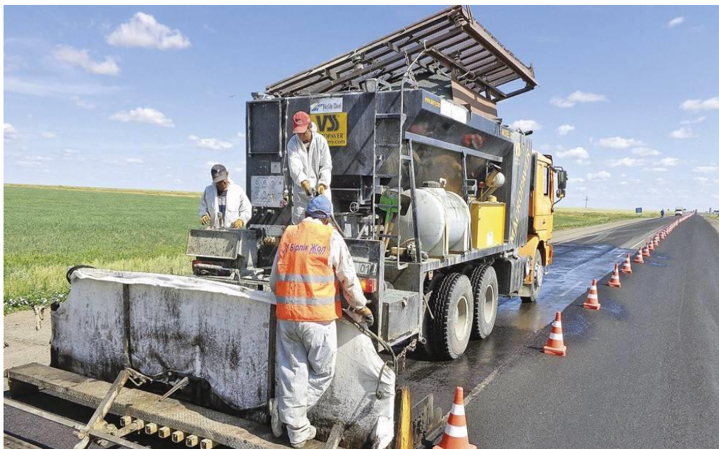
Рис. 1. Розлив эмульсионно-минеральной смеси
