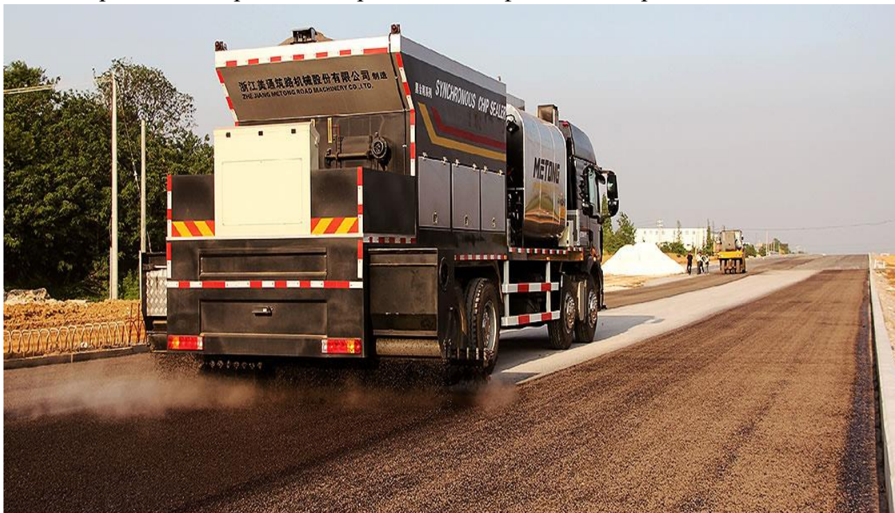
Рис. 2. Распределение битумной эмульсии с щебнем.
