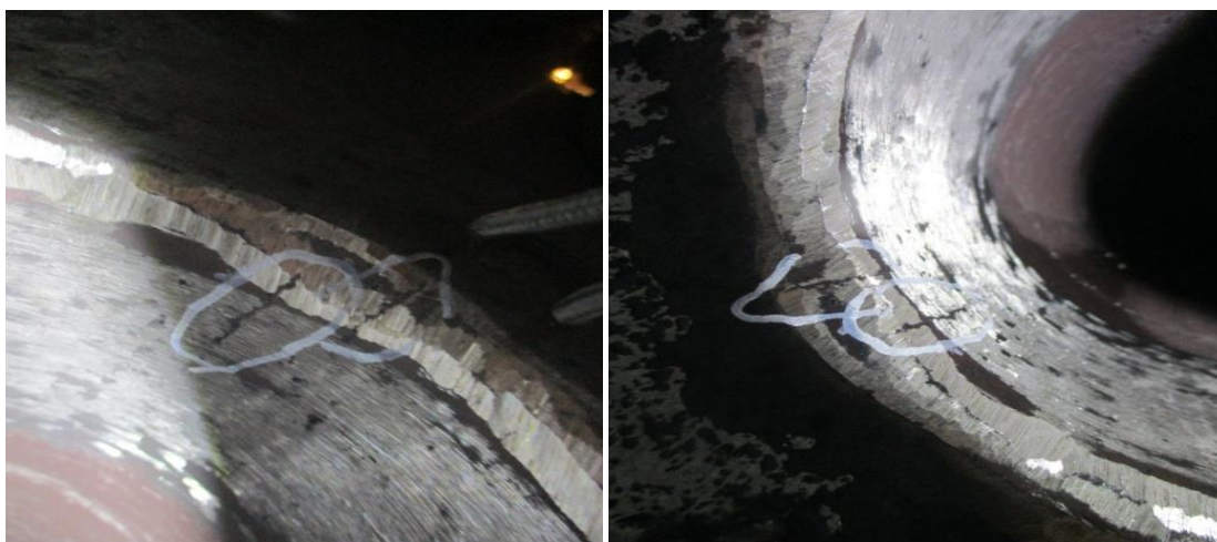
Рис.1 Трещины на отверстиях водоотпускных труб.
