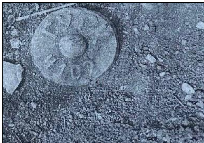
Рис. 4. Сохранившаяся марка геодезического пункта
