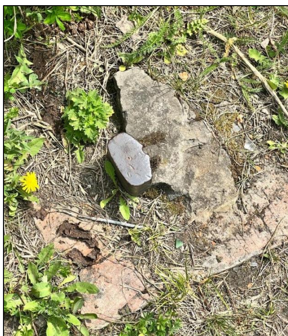
Рис. 2. Марка – центр государственного геодезического пункта
