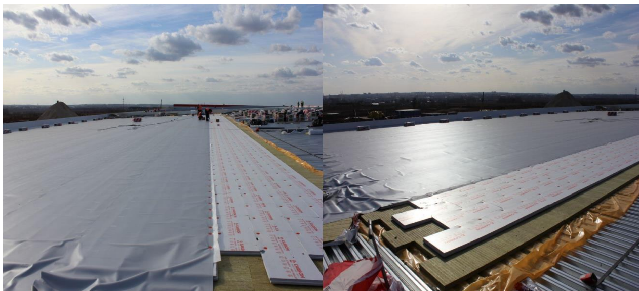
Рис. 1 Устройство кровли из рулонной ПВХ мембраны
