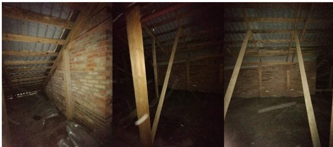
Рис. 1. Примыкание ската кровли к башням
