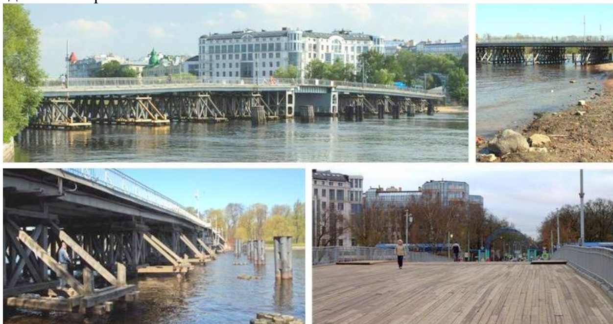
Рис.1. 2-й Елагин моста в Санкт-Петербурге
