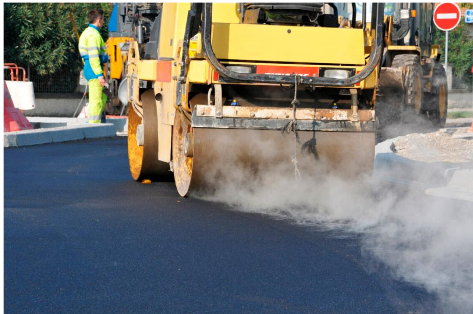
Рис. 1. Уплотнение асфальтобетонной смеси.
