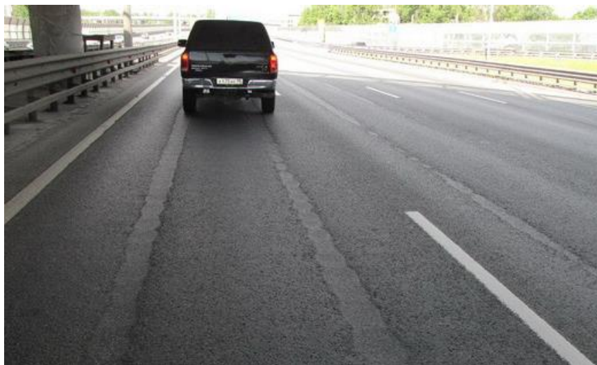
Рис.3. Общий вид абразивной колеи на левой полосе автомобильной дороги.
