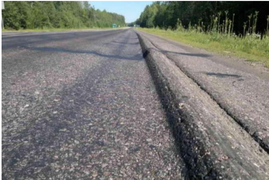
Рис.2. Пластическая колея с выпором асфальтобетона.
