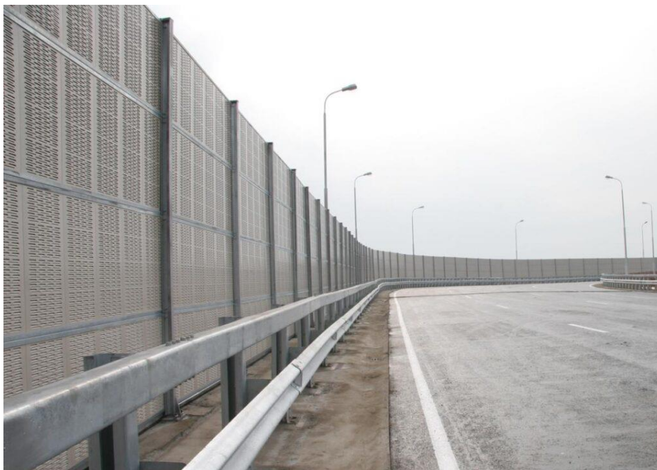
Рис. 2 – Пример шумозащитного экрана на автомобильной дороге
