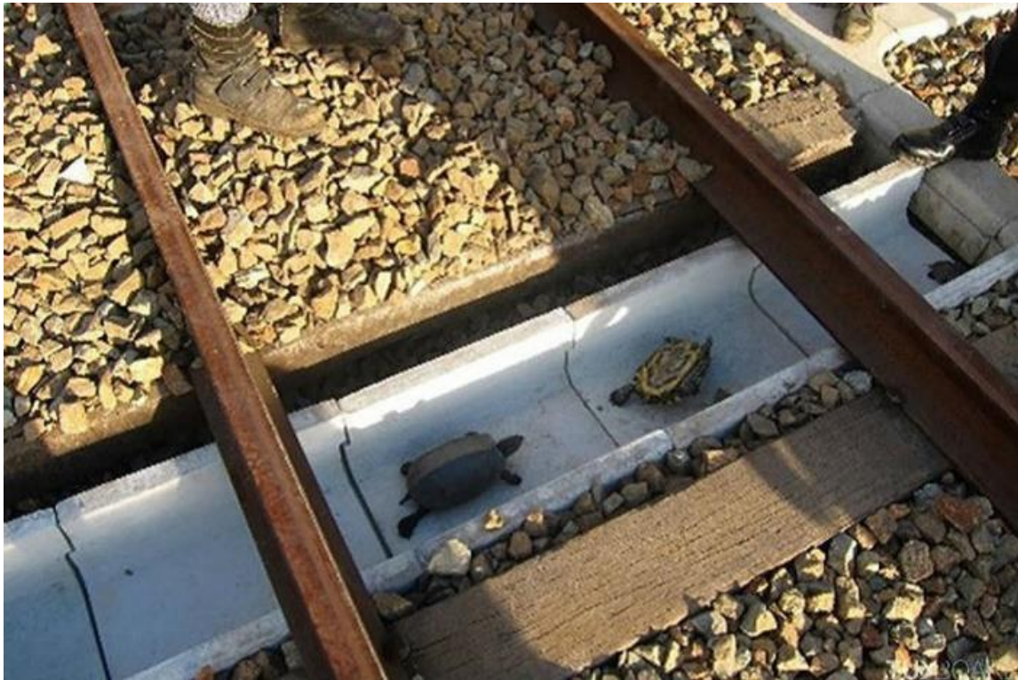
Рис. 4 - Туннель для перехода черепах через железнодорожные пути (Япония)
