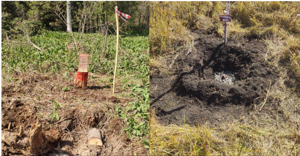
Рисунок 2. Способы долговременного закрепления центров базовых станций
