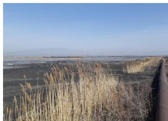
Рисунок 6. Последствия утечки пульпы из золопровода
