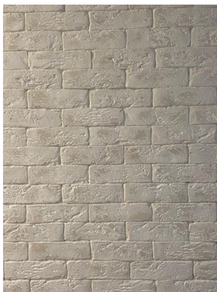
Рис.1. Отделка плиткой под кирпич стены
