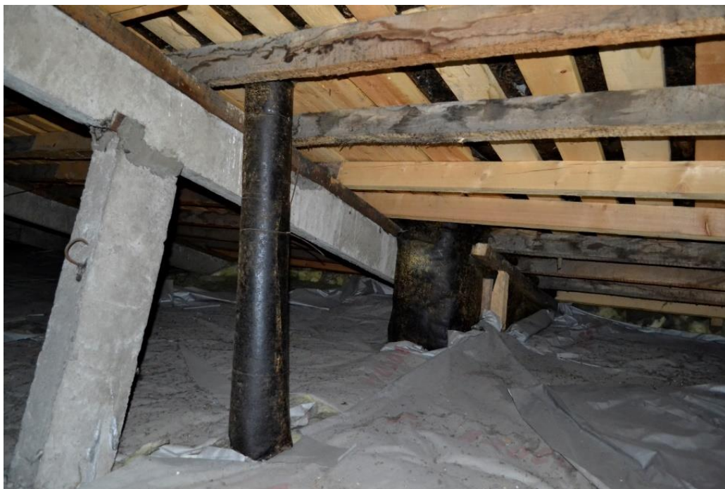
Рис. 4 Местное намокание элементов стропильной системы
