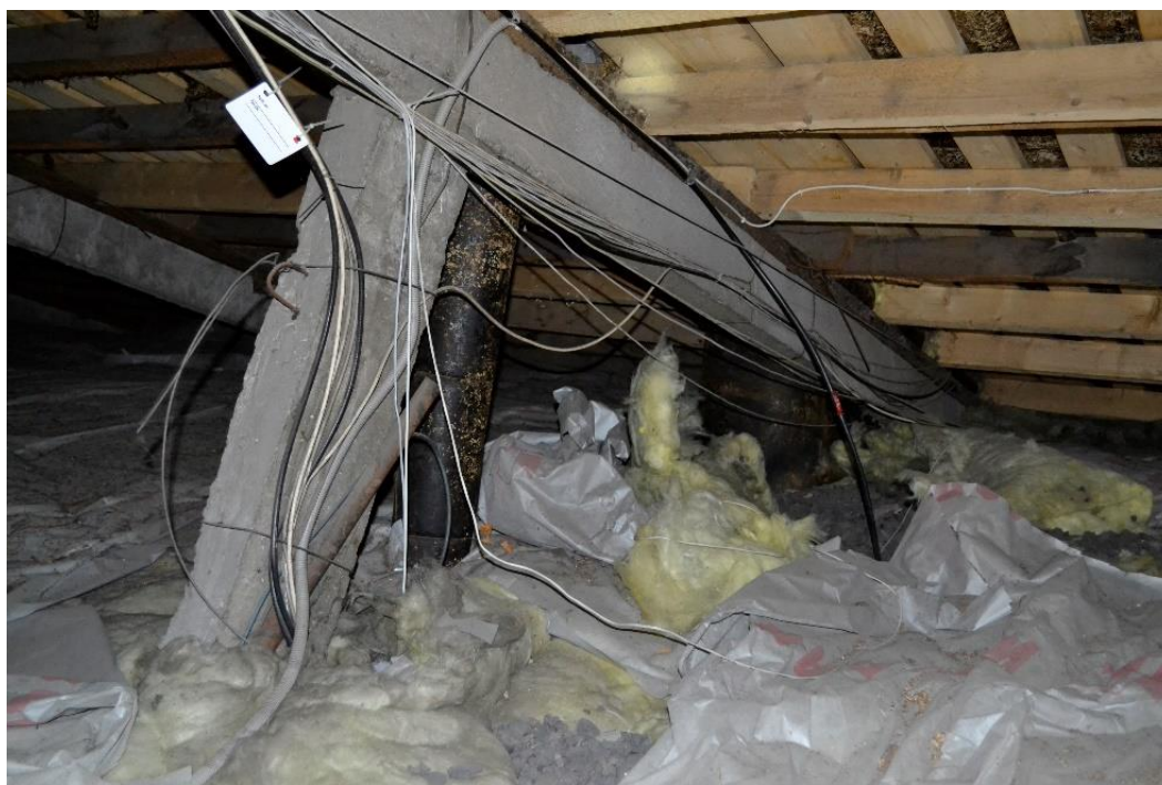
Рис. 5 Несоответствие утеплителя установленным нормам
