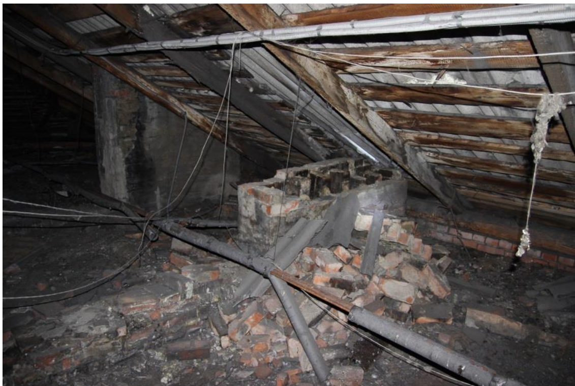
Рис. 5 Разрушение вентиляционной шахты
