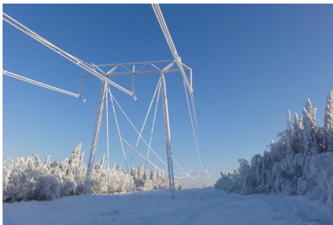
Рисунок 1. Гололед на проводах ВЛ
