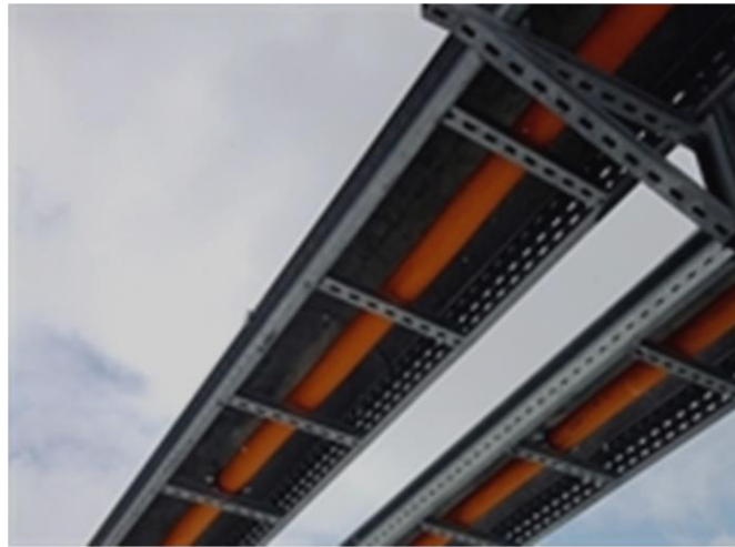
Рис. 2. Прокладка кабельных линий со СПЭ изоляцией для трансформаторной подстанции ТП 110/6 ЛПДС «Анжерская» г. Анжеро-Судженск
