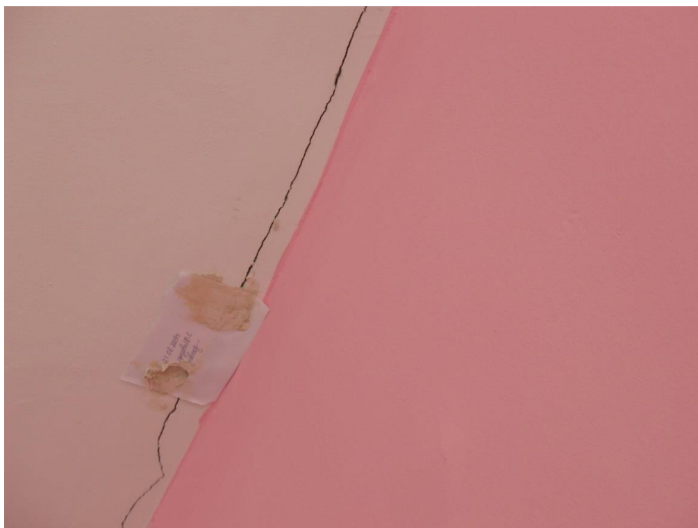
Рис. 12. Примыкание перегородки к покрытию
