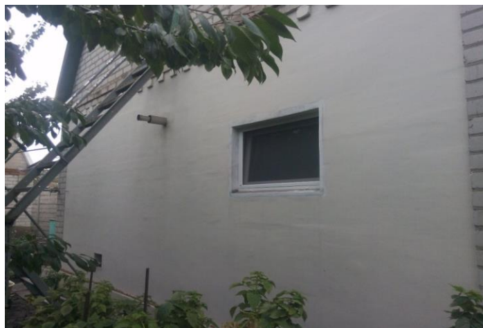
Рис.1. Фасад здания после монтажа первого слоя утеплителя
