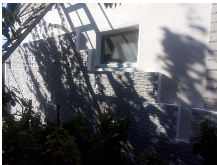
Рис.2. Фасад здания в процессе монтажа второго слоя утеплителя
