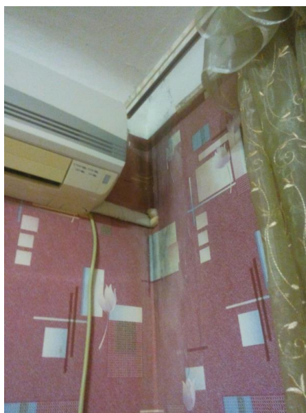
Рис. 4. Очаг протяженного грибкового поражения угловой части стены здания
