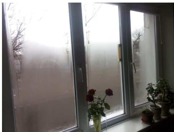
Рис.3. Образование конденсата на стеклопакетах
