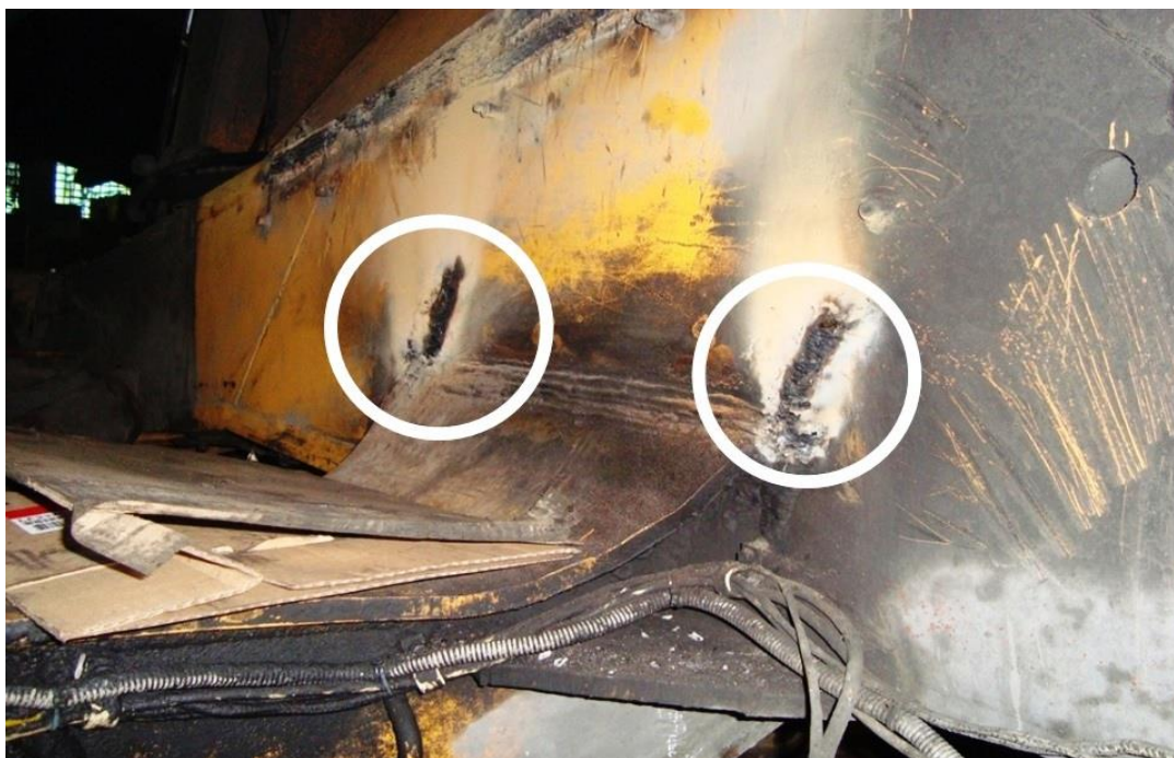
Рис. 1. Сварные швы на поперечине передней оси
