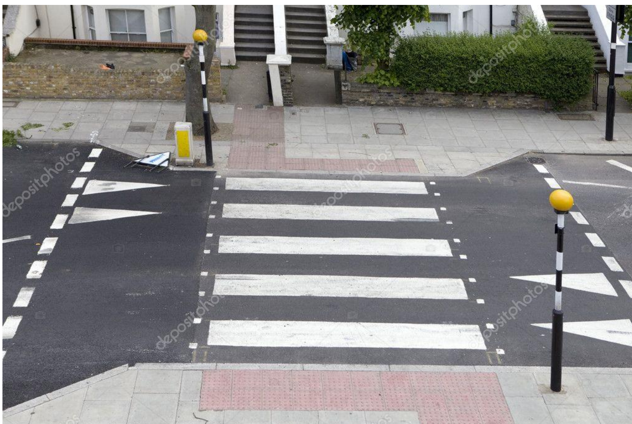
Рис. 3 Пешеходный переход с сужением проезжей части
